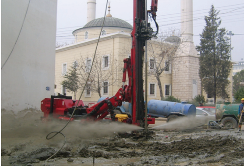
Şekil 4. Jet Grouting uygulama
