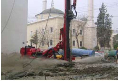
Şekil 4. Jet Grouting uygulama
